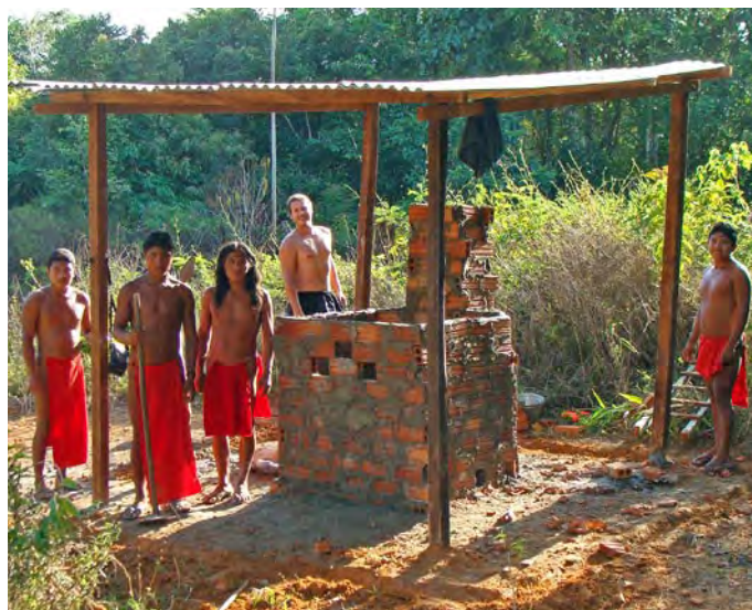
Construção de forno de queima de lixo na Terra Indígena Waiãpi.
