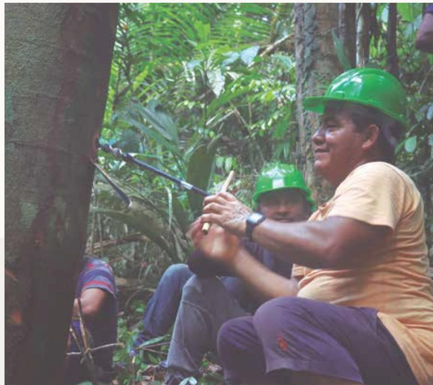
O furo deve ser feito a altura da cintura, entre 1 m e 1,5 m de altura, com o trado inclinado para cima, deixando o extrativista em uma posição confortável para fazer a perfuração.
